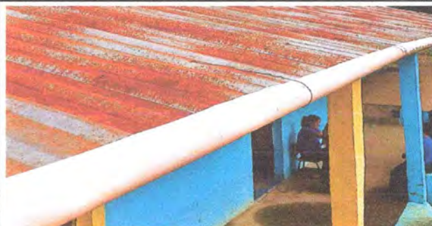
Foto 4: Sustitución de canal de pvc a canchales de metal liso
