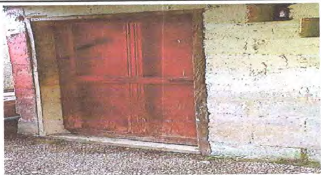
Foto 1: Sustrucción de puerta de madera a metal y sustrucción de candado a chapa
