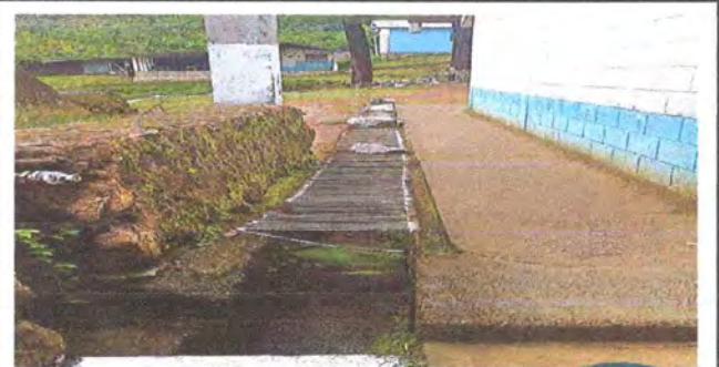
Foto 5: Reparación de cuneta de concreto y colocación de parrillas
