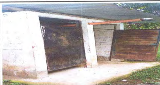
Foto 5: Reparación de la puerta cepillado, lijado y aplicación de pintura
