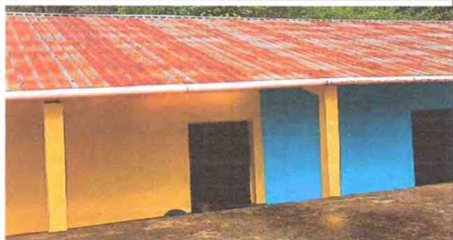
Foto 1: Sustitución de láminas troqueladas a láminas troqueladas
