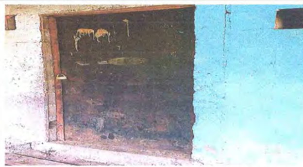
Foto 2: Mantenimiento de puerta lijada, cepillado y aplicación de pintura
