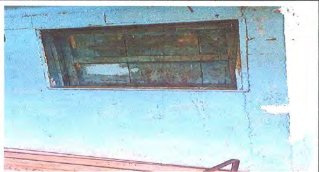
Foto 3: Sustitución de ventanas de madera por metal
